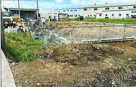
富山市婦中町添島の建設地
